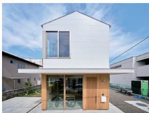
たなか邸 伊藤憲吾 伊藤憲吾建築設計事務所
